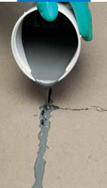
Επισκευή ρωγμής σε τσιμεντοκονία με Eporip
