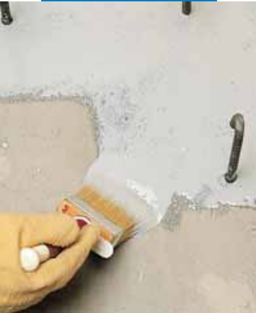
Εφαρμογή του Eporip με πινέλο σε κατασκευαστικό αρμό
