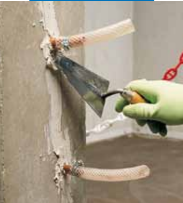
Στερέωση σωλήνων ενεμάτων και σφράγιση ρωγμών για δομική σταθεροποίηση
