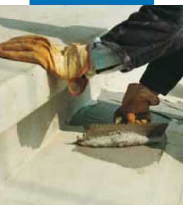
Εφαρμογή Adesilex PG1 με οδοντωτή σπάτουλα για δομική συγκόλληση προκατασκευασμένων σκαλοπατιών
