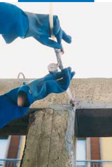
Εφαρμογή Adesilex PG1 σε υποστύλωμα
