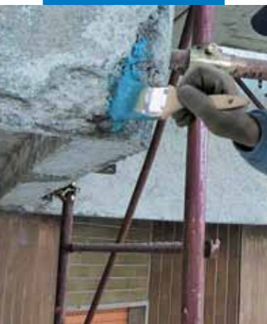
Εφαρμογή του Mapofer 1K με βούρτσα σε ράβδους οπλισμού μπαλκονιού από οπλισμένο σκυρόδεμα
