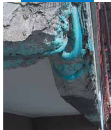
Ράβδοι οπλισμού εμπρόσθιας όψης μπαλκονιού επεξεργασμένοι με Mapefer 1K
