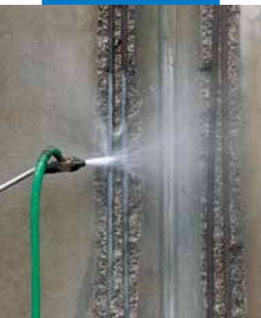
Καθαρισμός ράβδων οπλισμού
