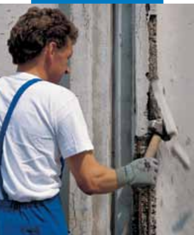
Αποξήλωση αποσθρωμένου σκυροδέματος
